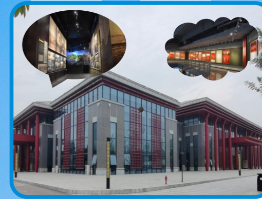
渭南军事博览园国防教育馆展陈设计、施工一体化工程 (位于临渭区赤水镇, 建筑面积9805m², 展陈面积约7145m²)
