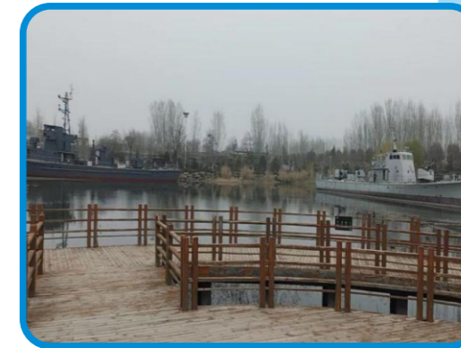
渭南军事博览园人工湖舰艇基础、景观工程 (位于临渭区向阳办赤水村军事博览园内)
