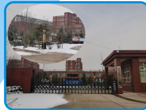
临渭区中心敬老院2#、3#楼及室外景观绿化工程 (位于临渭区阳郭镇)
