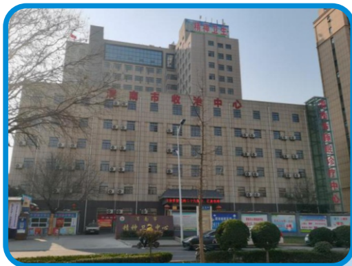
渭南市精神卫生中心住院楼工程 (位于临渭区新区东路, 建筑面积9135m²)
