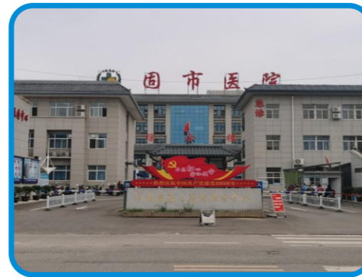
渭南市第二医院固市分院项目 (位于临渭区故市镇)
