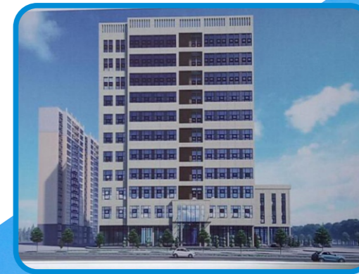
渭南市儿童福利院康复中心大楼项目 (位于儿童福利院院内)
