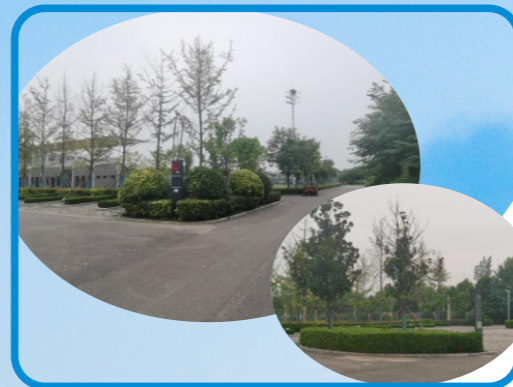
渭南军事博览园室外景观工程 (位于临渭区向阳办赤水村)
