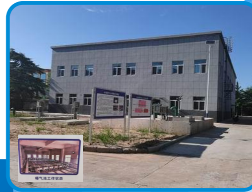
渭南高新区自来水厂水质改造提升工程 (位于渭南高新区自来水厂内, 总建筑面积1358m²)
