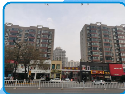
渭南豪润御城A、C座住宅楼 (位于临渭区东风大街中段)
